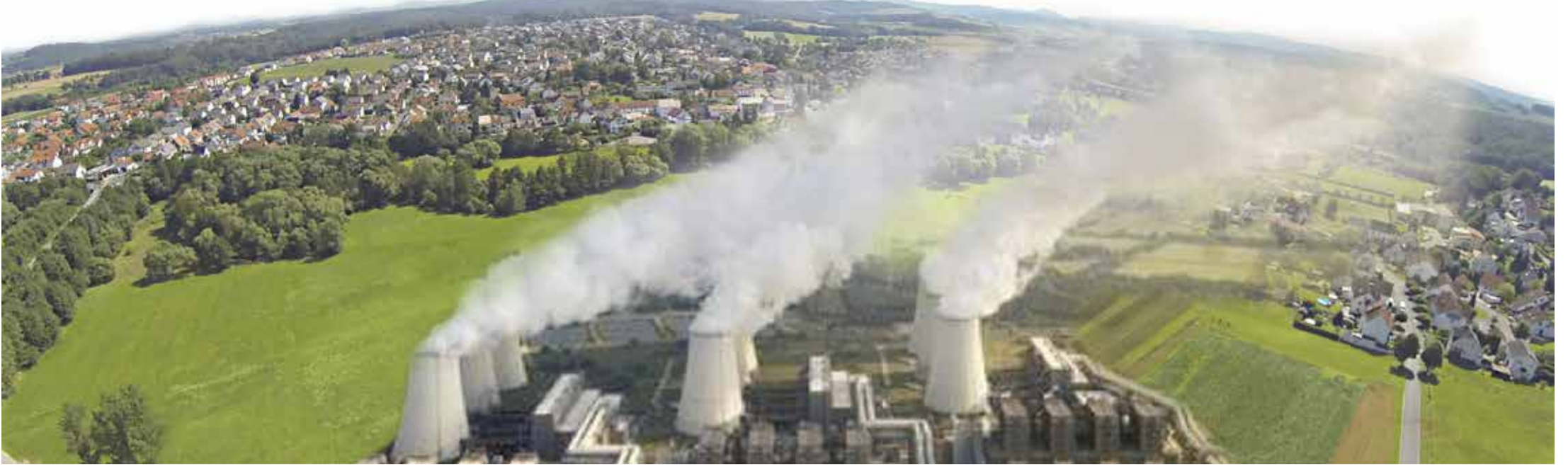
So kann Eichenzell bald aussehen. Es werden deutliche Mehreinnahmen bei der Gewerbesteuer erwartet. (Foto: AGORA)
