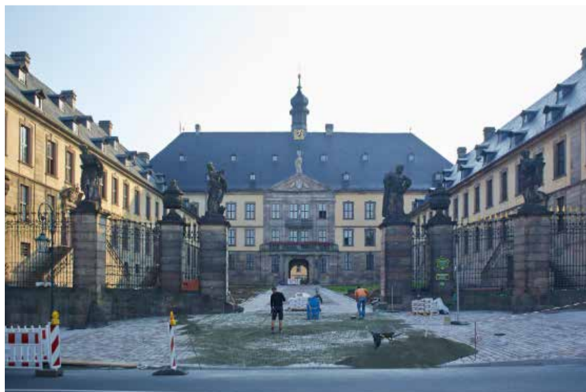
Diese Gebäude sind ein Trauerspiel, als nächstes das Stadtschloss? (Fotos: AGORA, Jens Brehl CC BY-NC-SA 4.0)
