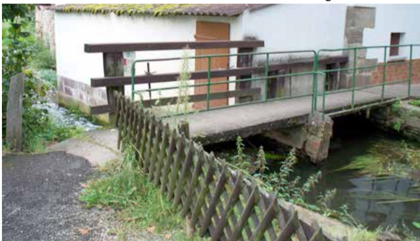
Der Standort der Mühle in Ziegel (Foto: AGORA)
